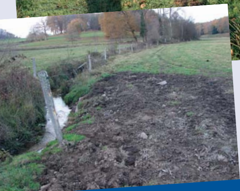
Restauration de berge sur le Grandrieux
