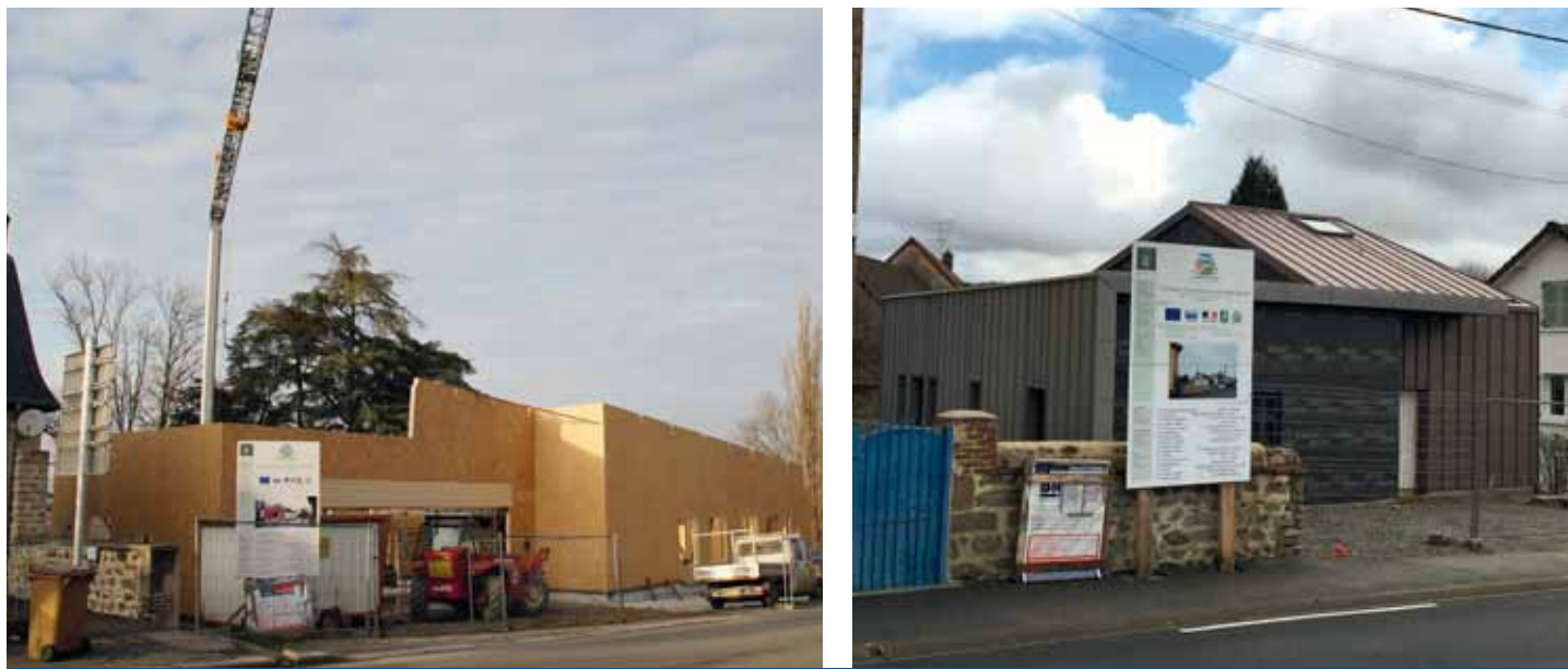
Les deux chantiers de la MSP, à Bourgneuf (à gauche) et à Saint-Dizier-Leyrenne (à droite).
