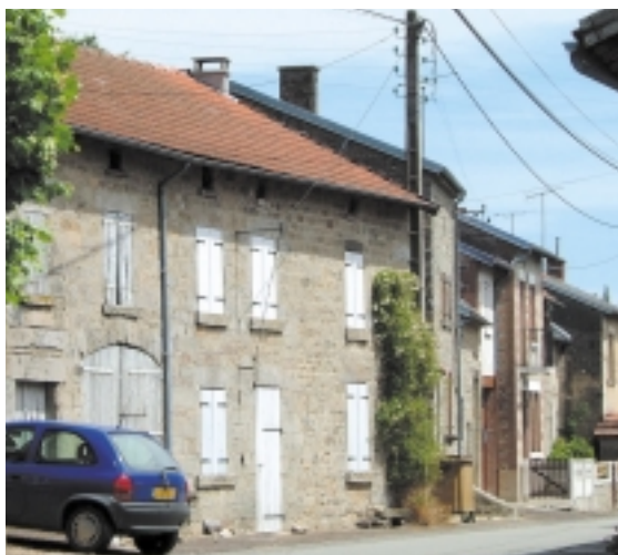
Trop d'habitations demeurent vacantes ou insalubres.
